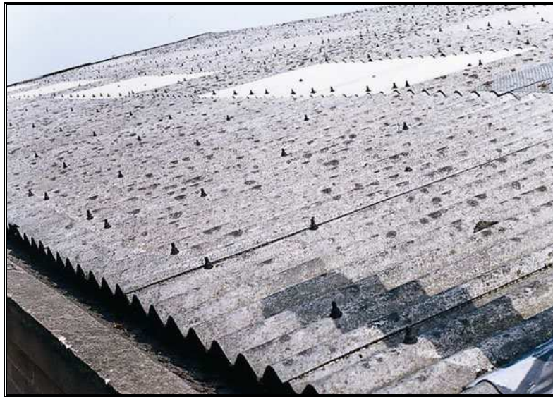
Rysunek 1. Dach pokryty azbestową płytą falistą
