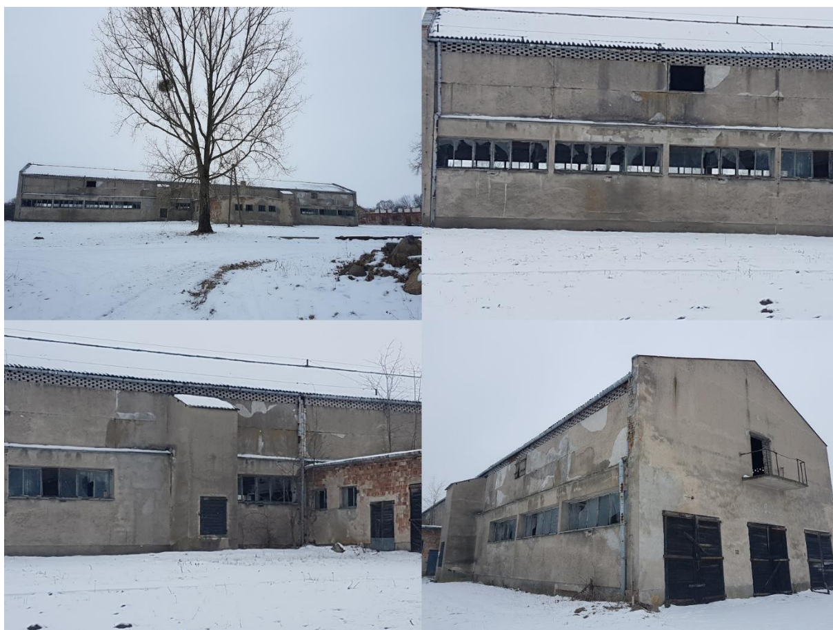
RYSUNEK 26. DOKUMENTACJA FOTOGRAFICZNA - BUDYNEK BYŁEGO PGR
